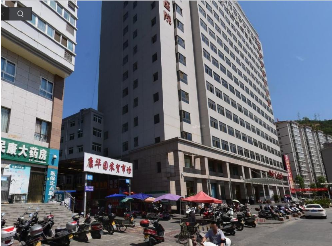
图 1-3 门诊大楼图片
