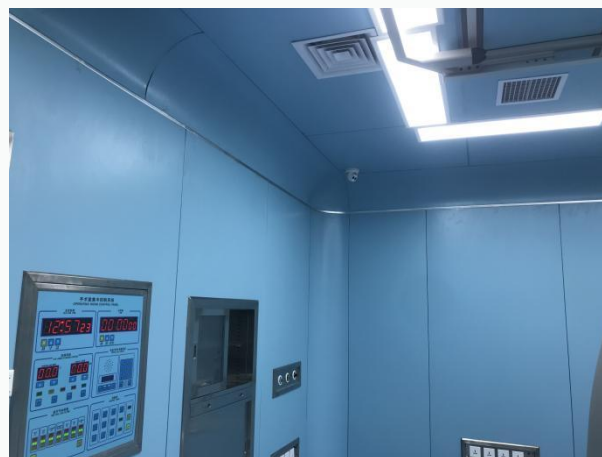
图 3-10 机房顶部通风口
