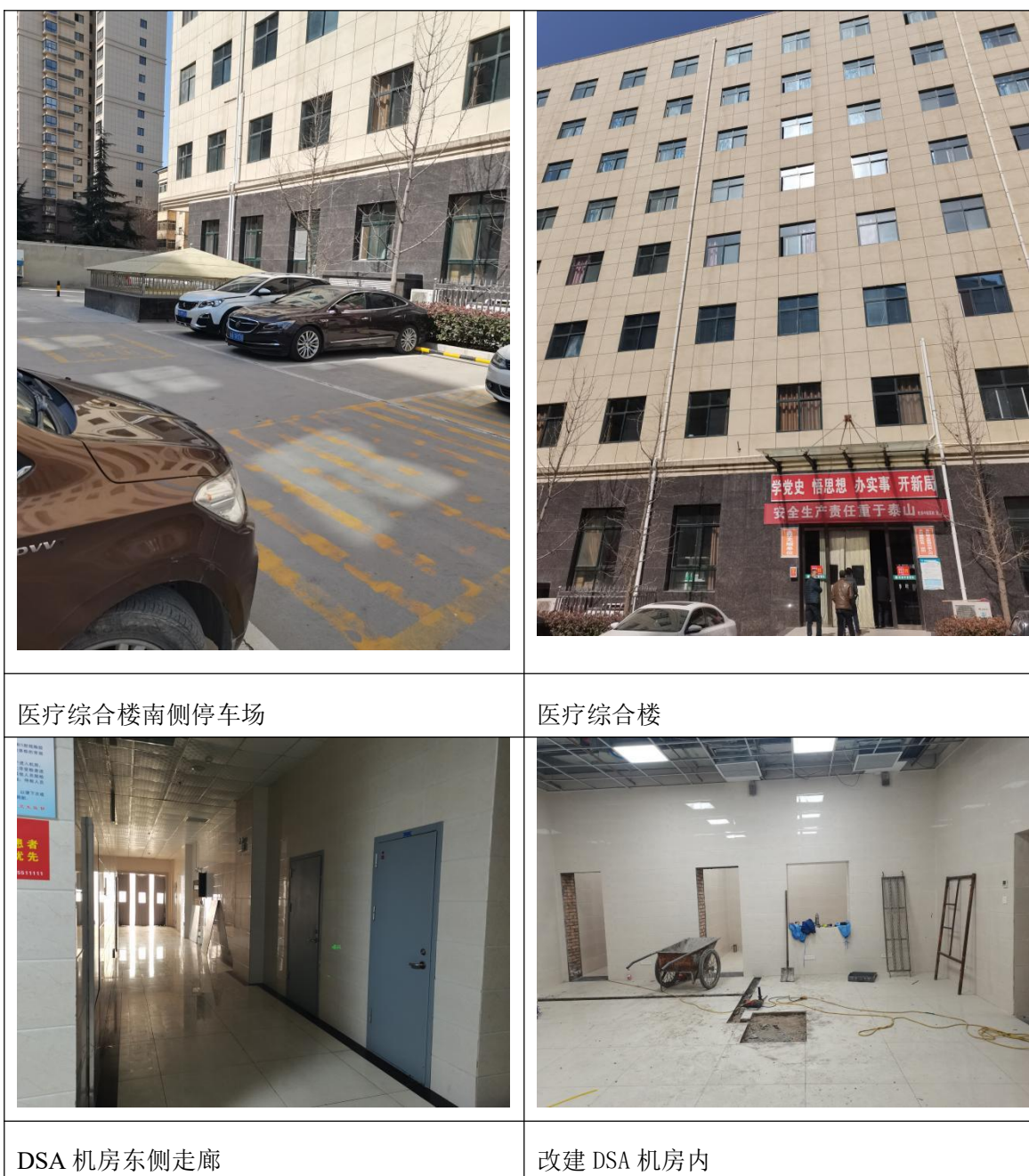
图 8-1 DSA 机房周围环境现状照片
