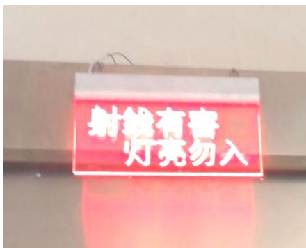
图10-18 工作状态指示灯、电离辐射警告标志示例图
