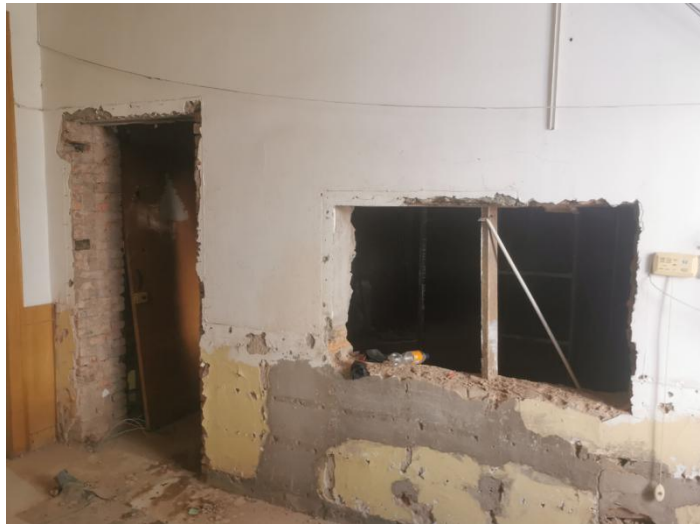
图8-12 北墙预留门洞、观察窗位置
