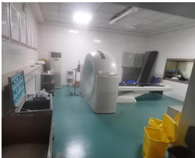
图8-6 后装治疗机房内部
