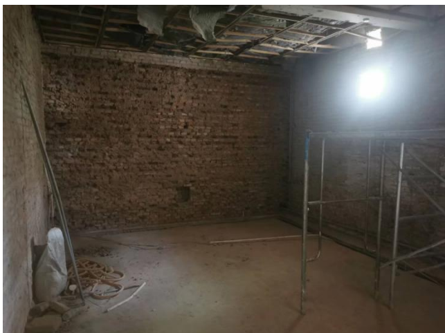
图8-10 大孔径CT模拟定位机房
