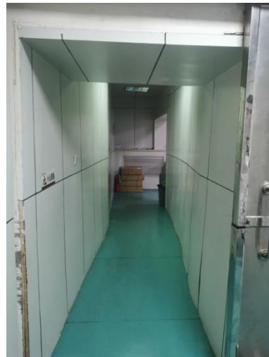
图8-7 后装治疗机房迷路
