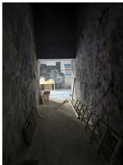
图8-2 加速器机房迷路
