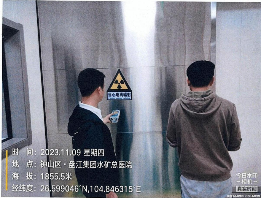
图1 医院一楼放疗中心直线加速器机房现场监测图
