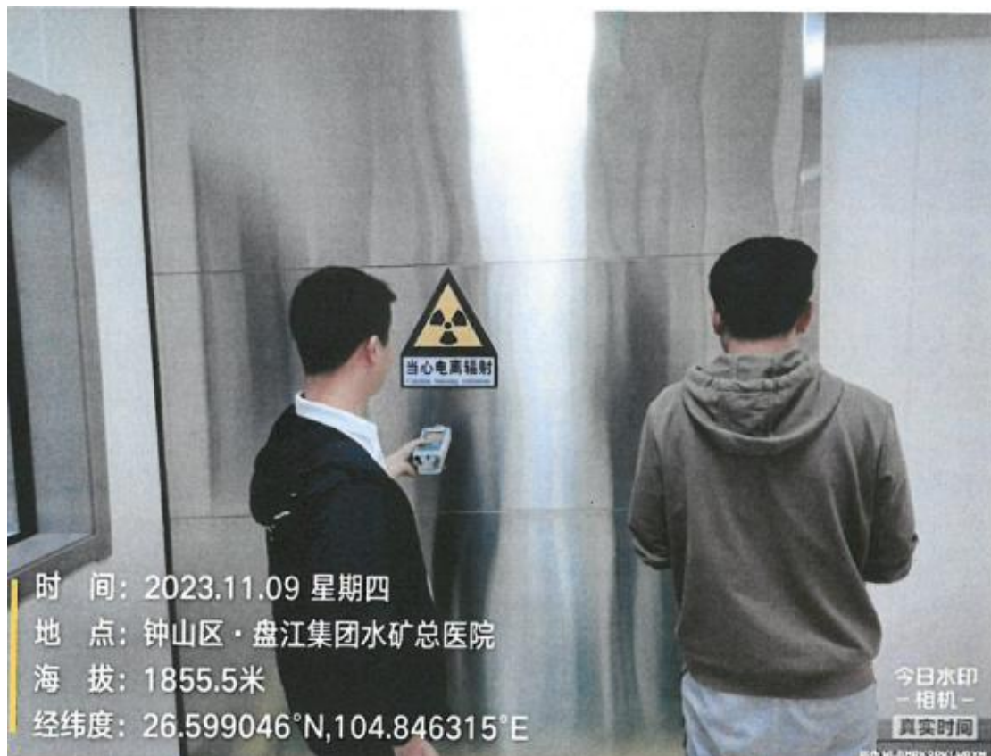
图 9-1 医院一楼放疗中心直线加速器机房现场监测图
