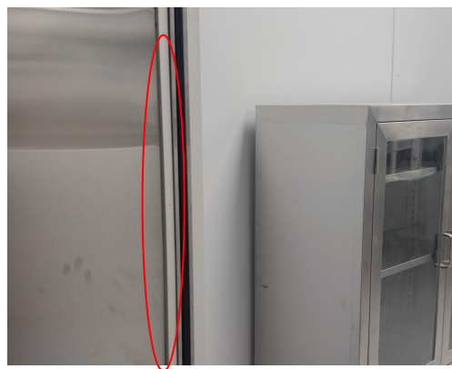
图 3-9 患者门上红外防夹装置照片
