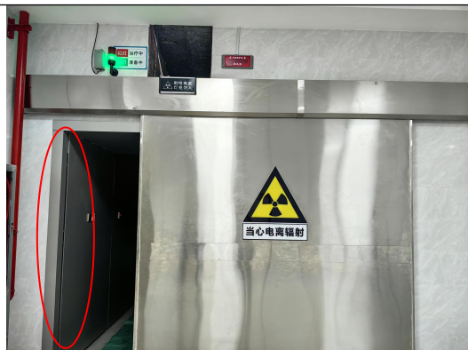
防护门光幕式红外防夹装置
