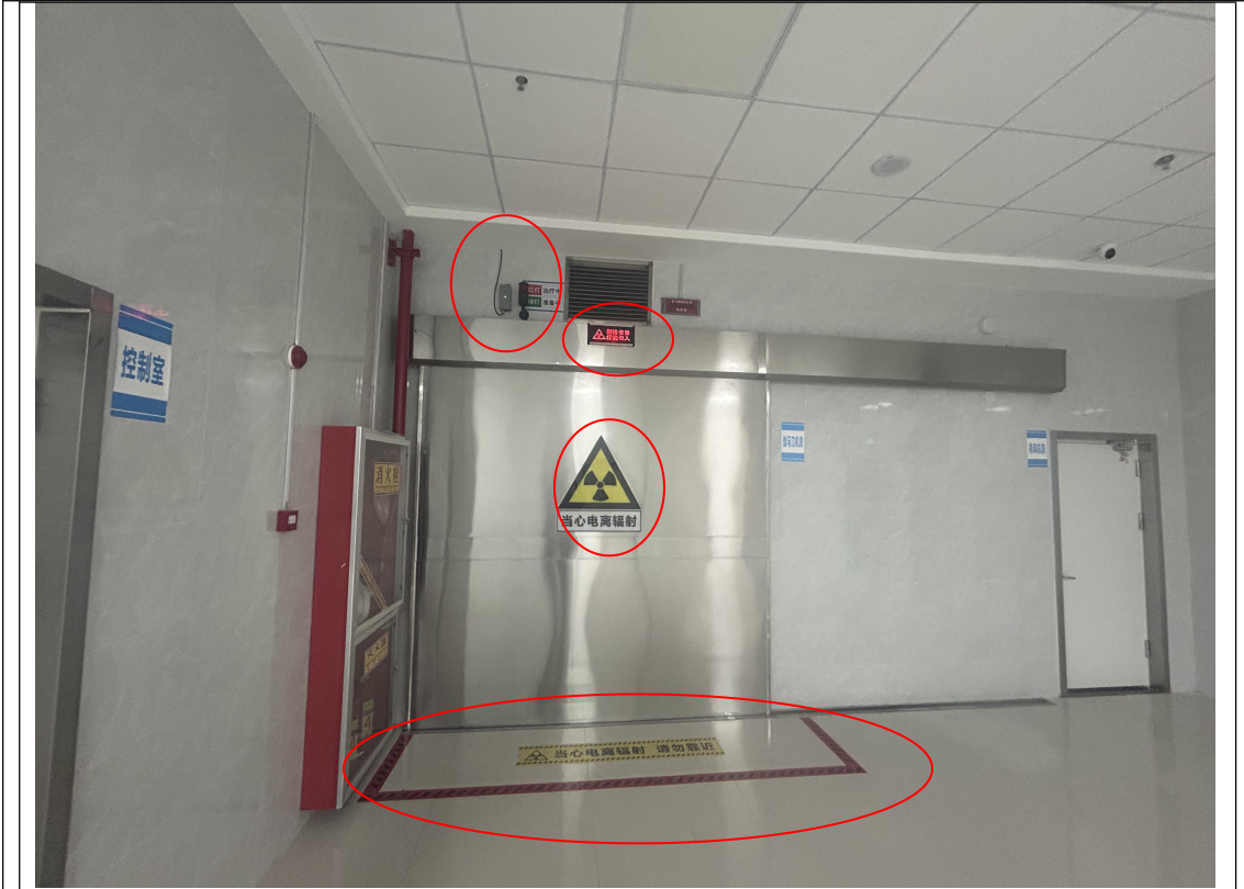
机房防护门外安全警示设施
