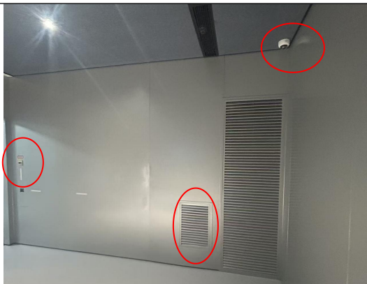
治疗室前仓西北角
