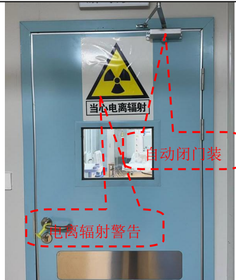
DSA 机房污物防护门
