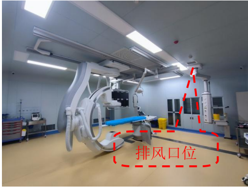
DSA 机房排风口
