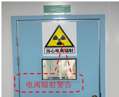
DSA 机房工作人员防护门
